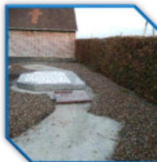
Pendant les travaux
